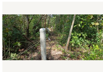
Poste para delimitación del DDV.
