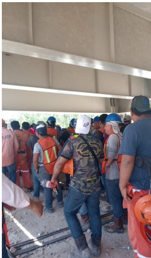
Personal de obra bajo el viaducto.
