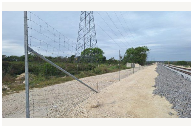
Confinamiento perimetral junto a la vía férrea.
