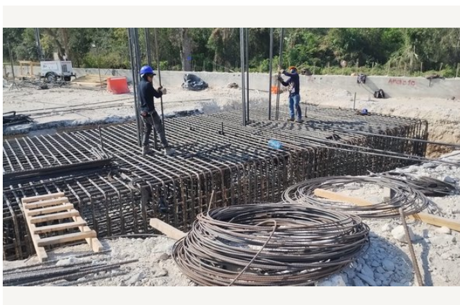
Habilitado de acero de refuerzo.
