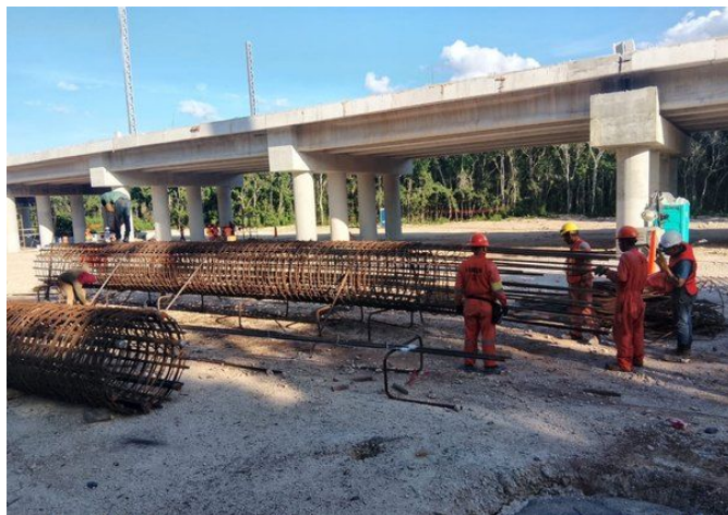
Armado de acero para elementos de subestructura.
