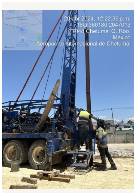
Perforación con equipo montado en camión.
