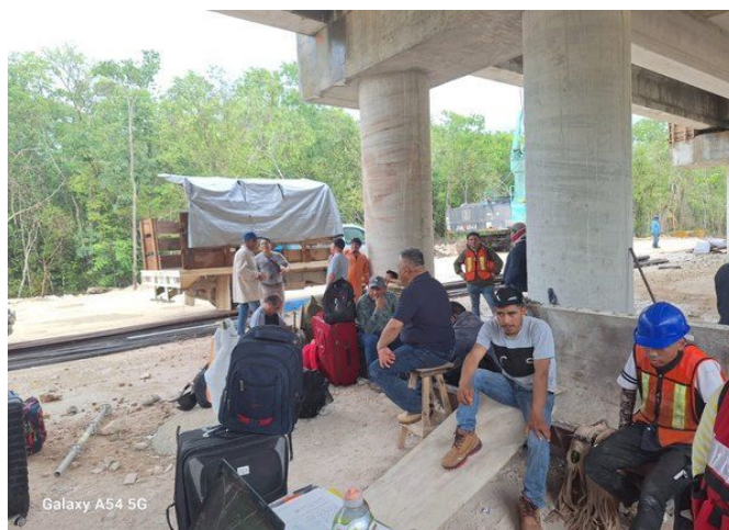
Personal de obra en el frente del viaducto.
