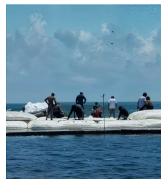
Arrecife de Concreto
