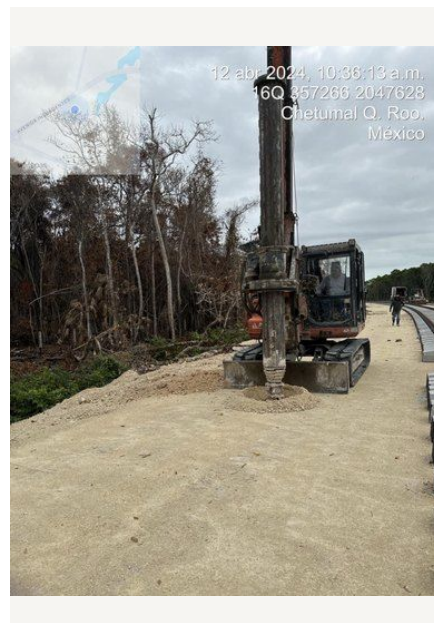
Perforación con equipo sobre orugas.
