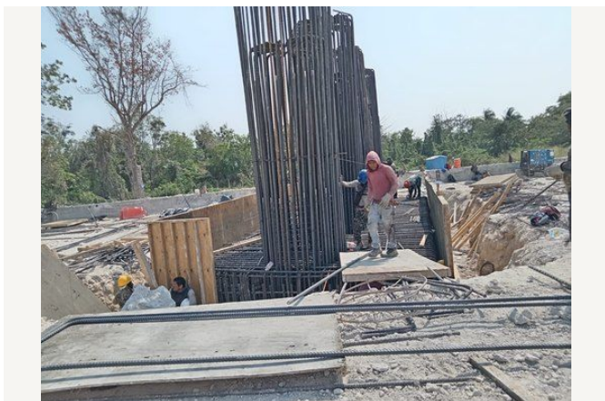
Cimbrado de elementos de cimentación.
