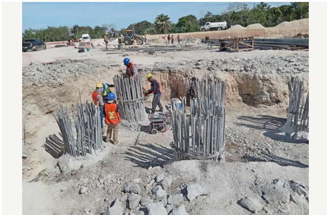
Trabajos en elementos de cimentación profunda.
