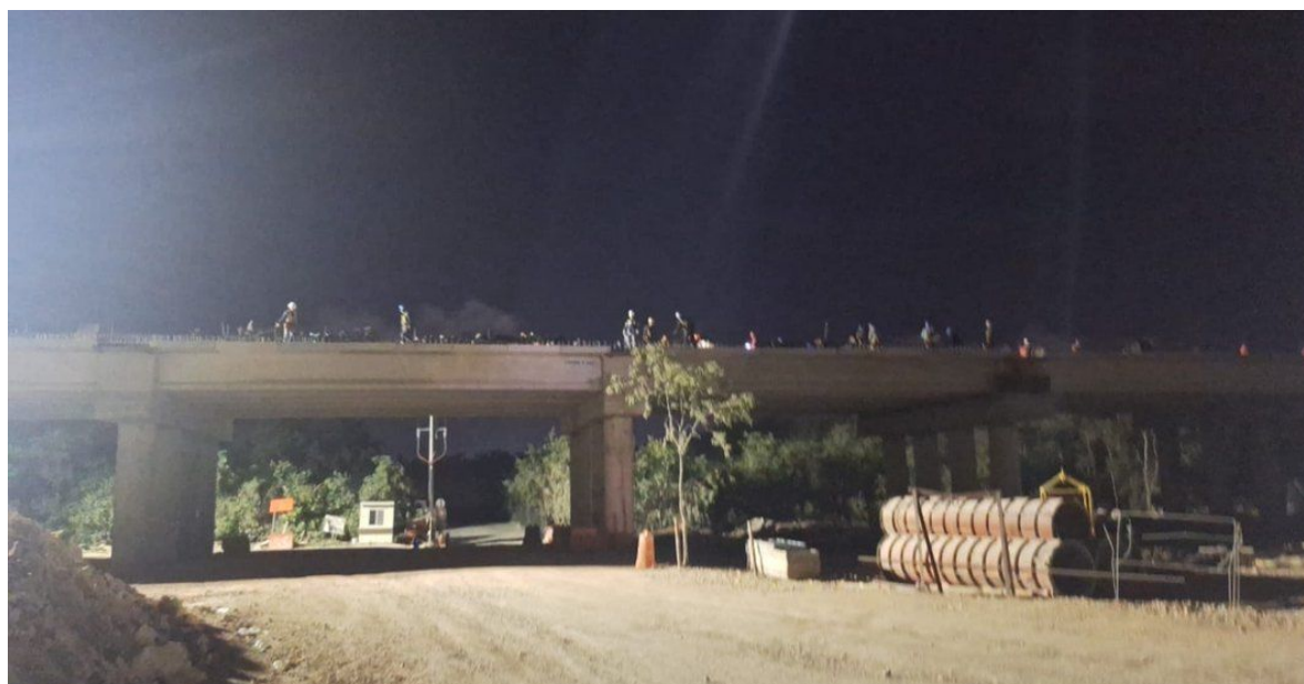
Trabajos nocturnos en el viaducto elevado.
