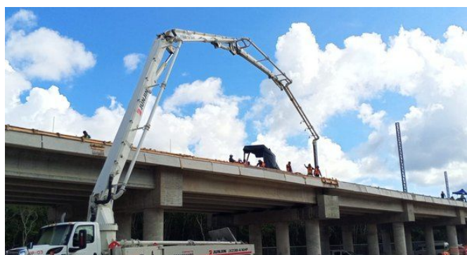
Colado de superestructura con bombeo de concreto.
