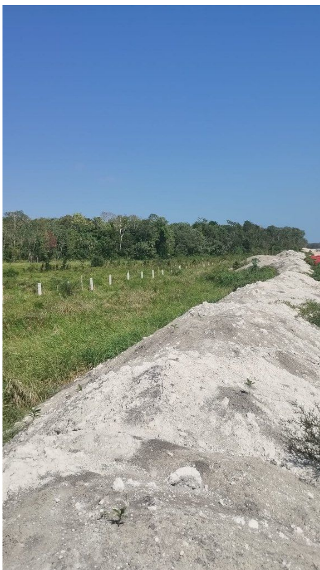
Confinamiento del derecho de vía.
